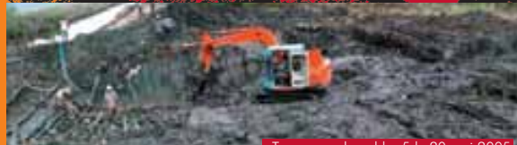
Travaux sur le polder 5 le 20 mai 2005
